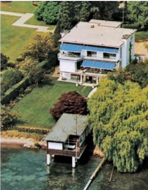
Die ehemalige Villa Seestrasse 264 in Küsnacht (vor dem Umbau).
