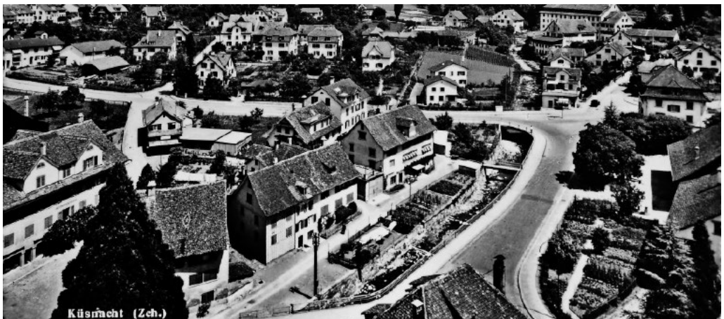
Die Häuser am Bach (Bildmitte), wovon mehrere dem Neubau des Gemeindehauses weichen mussten.
