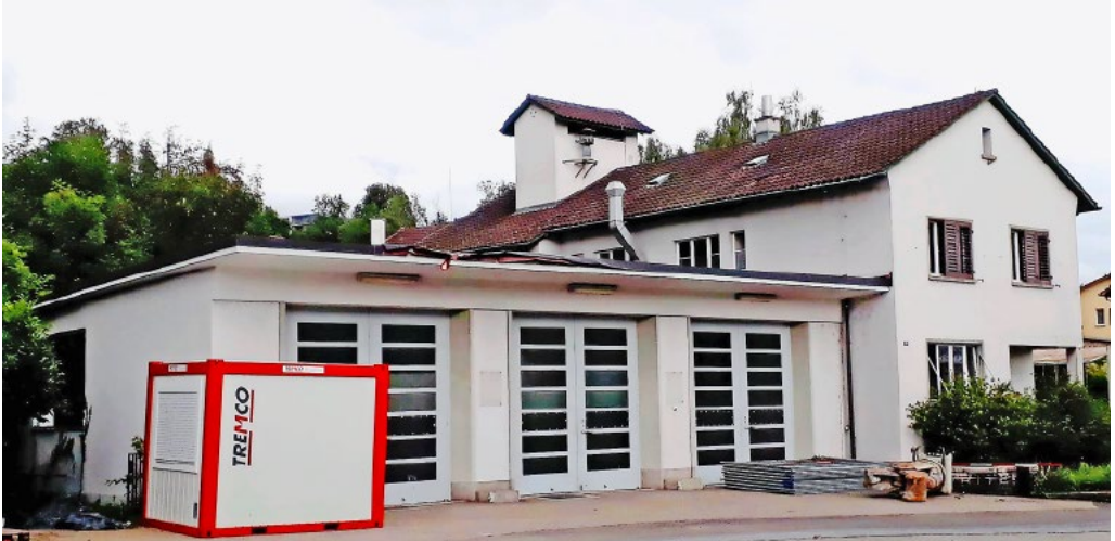
Ein letzter Blick auf das bisherige Depot der Feuerwehr Künsnacht aus dem Jahre 1936, das einem vom Souverän bewilligten Neubau weichen muss. 8. August 2021. Foto: Martin Bachmann.
