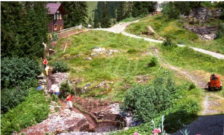
Ende Juli 76: Unsere Equipen spitzen mit Bau-Kompressor eine Grube für die Kläranlage aus dem harten Schiefer heraus und heben einen verzweigten Graben für die Abwasserkanalisation dreier Häuser aus.
