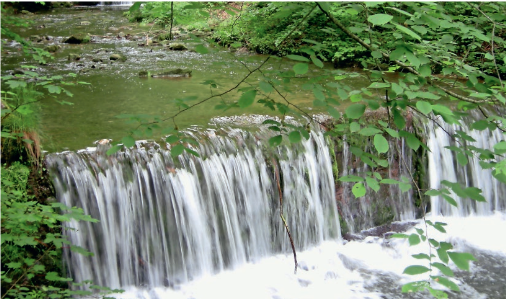
Die Wirkung von Bachsperren: Ruhiger Abschnitt, Wasserfall und Tosbecken.
