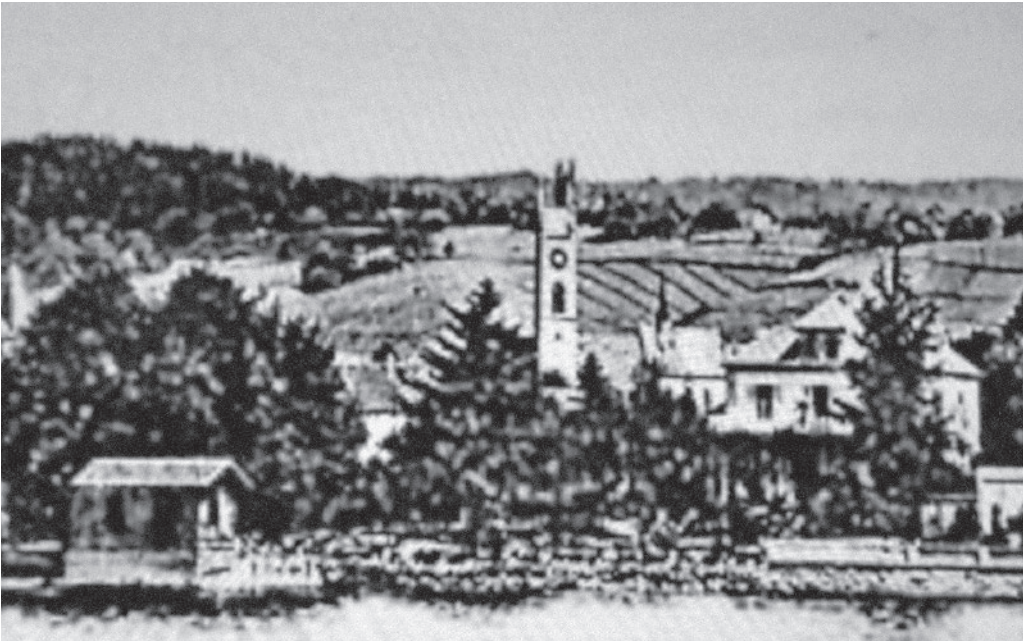
Ausschnitt aus einer undatierten Ansichtskarte von 1893. Die neue Villa mit Bootshaus, umgeben von Rebland. (Kant. Denkmalpflege Zürich)
