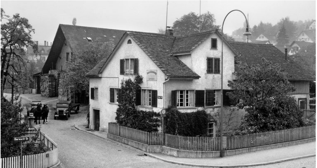
Das Bauern- und Geschäftshaus der Familie Günthardt an der Eigenstrasse 7.
