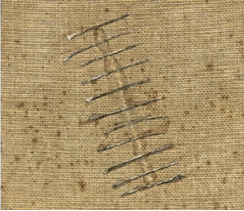
Der Riss wird auch rückseitig verklebt und zusätzlich mit Fadenbrücken stabilisiert.
