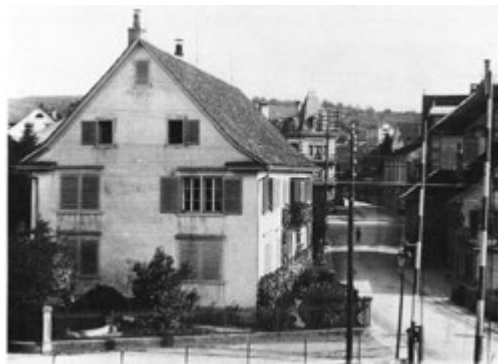
Blick dorfaufwärts bei der Barriere.
