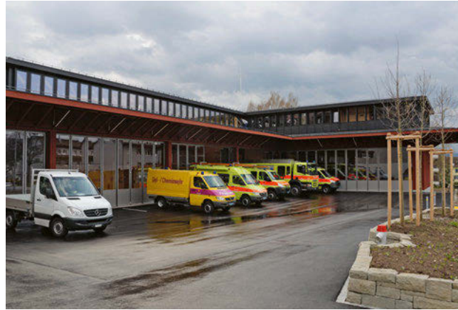
Ein in allen Teilen gelungenes Bauwerk wurde im Rahmen eines «Blaulichtages» am 13. Mai 2023 offiziell eingeweiht.
