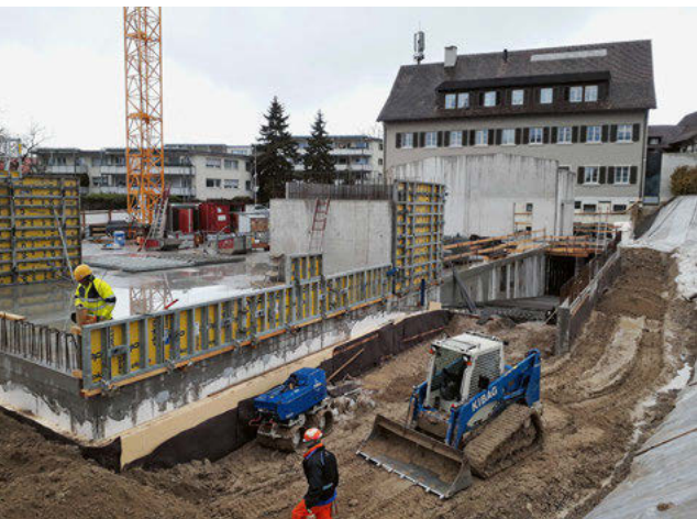
Die Arbeiten im Untergrund nehmen Gestalt an, Februar 2022.
