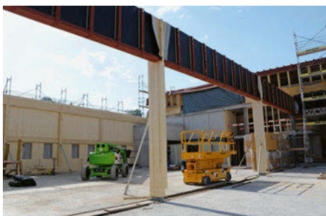
Die Holzkonstruktion der grossen Einstellhalle wird sichtbar, Juni 2022.
