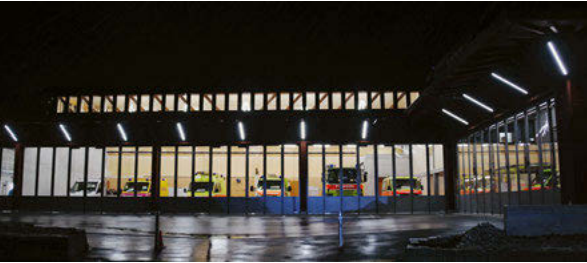
Zum Ausrücken bereit! Auch zur Nachtzeit zeigt das Feuerwehrdepot seine gelungenen Konturen.
