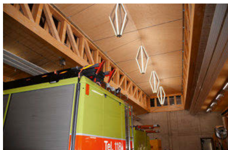
Die Feuerwehrfahrzeuge stehen in Reih und Glied. Im Januar 2023 kann das Feuerwehrdepot den Einsatzkräften übergeben werden.
