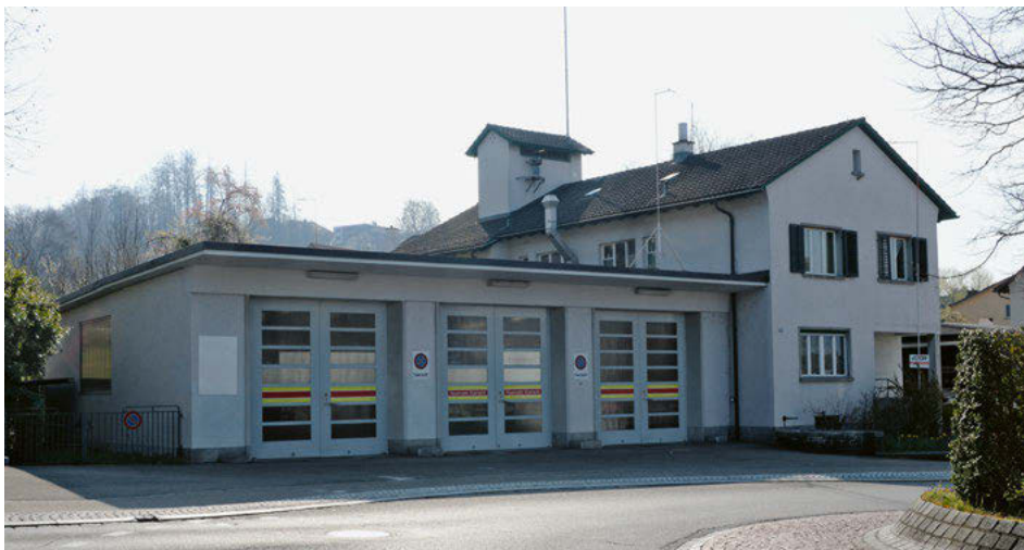
Altes Feuerwehrgebäude 1936–2021. Foto: Martin Bachmann, Küsnacht
