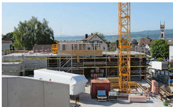
Die Betonarbeiten sind weitgehend abgeschlossen, Mai 2022.
