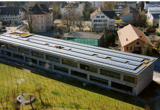
Solarpanels auf dem Dach des neuen Klassentrakts der Kantonsschule.
