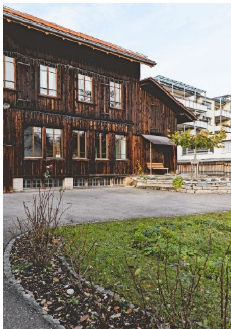
Zimmerei mit Werkstatt sowie ein Schopf als Lager. Zur Schreinerei gehört ein Spritzwerk, 2022.
