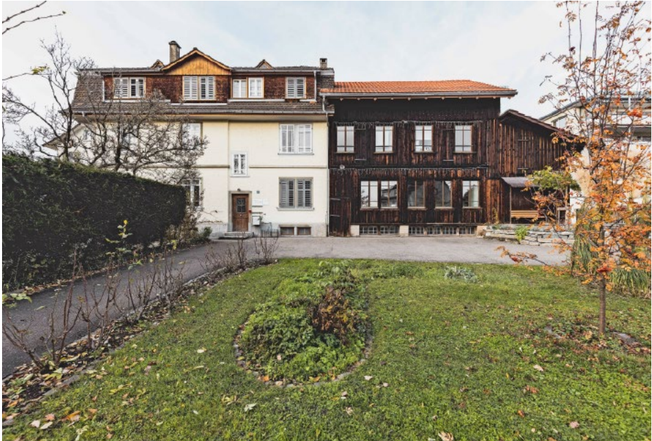
Das Haus an der Oberwachtstrasse 15, das sogenannte Riegger-Haus, wurde 1894 vom Zimmermeister Lorenz Riegger erbaut. Es umfasst ein massiv gemauertes Wohnhaus mit Büroteil und Gesellenzimmern, eine Zimmerei mit Werkstatt sowie einen Schopf als Holzlager. Zustand 2022. Foto: Pawel Streit
