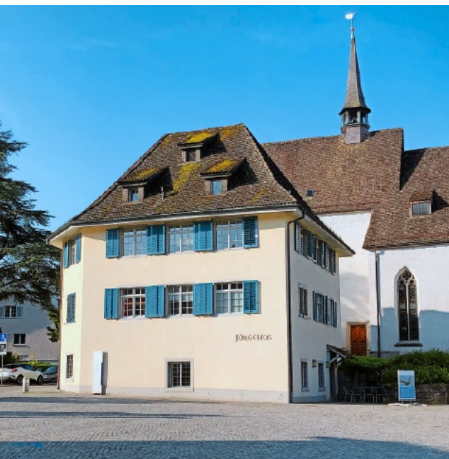
Abb. 15: Ansicht des Jürgehus, an dem die Fassadengestaltung verbessert worden ist. Seit 2001. Foto: Christian Marty, Küssnacht
