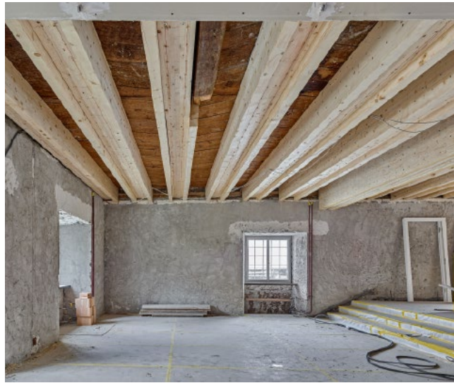
Abb. 16: Die neu eingezogenen Deckenbalken ermöglichen den Blick auf den alten Blindboden, 2022. Foto: Roger Frei, Zürich
