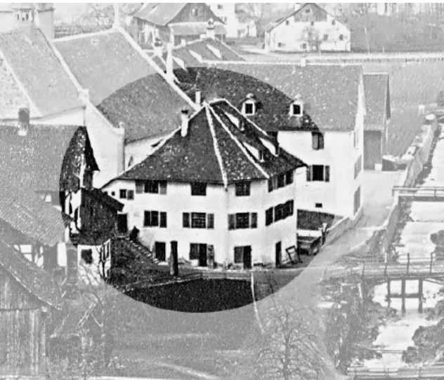
Abb. 10: Ansicht des alten Schulhauses mit dem gemauerten Anbau und der neuen Treppe, um 1870, Ausschnitt einer Postkarte. Bild: Archiv Ortsgeschichte Küssnacht, Nr. 026114
