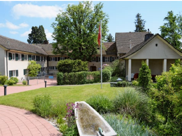
Das Areal im Hörnli umfasst verschiedene Gebäude. Die Villa Seeried wurde in den Jahren 2011/12 total saniert und diente in früheren Jahren zur Unterbringung von Menschen mit Demenz. Dieses Haus ist denkmalgeschützt. Foto: Martin Bachmann
