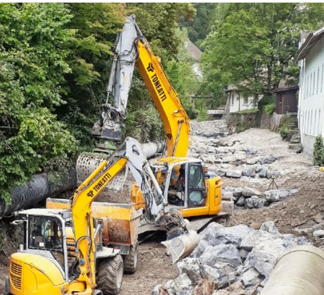
Bauarbeiten am Dorfbach Küsnacht. Foto: Martin Bachmann
