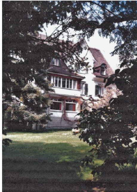
Kohlrainstrasse 5, Aufnahme vom Garten aus. Foto: Familien Archiv Baumann-Kägi
