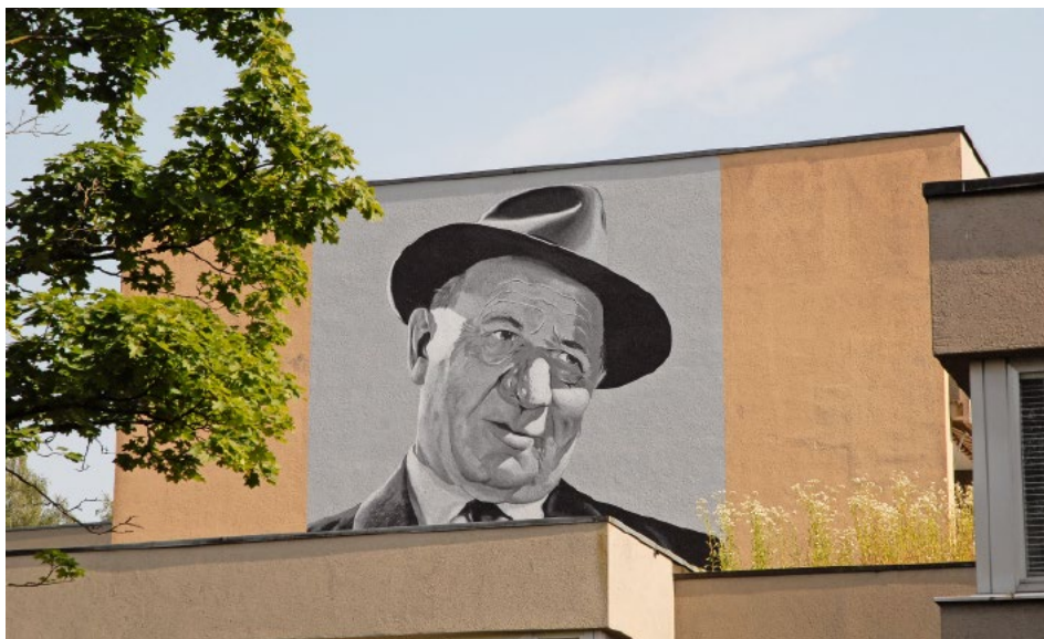
Das Alterswohnheim Tägerhalde vor dem Abbruch mit Wandgemälde des bekannten Schauspielers Heinrich Gretler (1897–1977). Foto: Martin Bachmann
