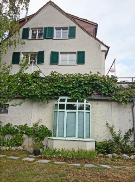
Gebaut: Der Erker im bestehenden seeseitigen Anbau als Lichtquelle für den neuen Raumteil im Kellergeschoss. Planung: Beate Schnitter, Foto: Martin Lehmann
